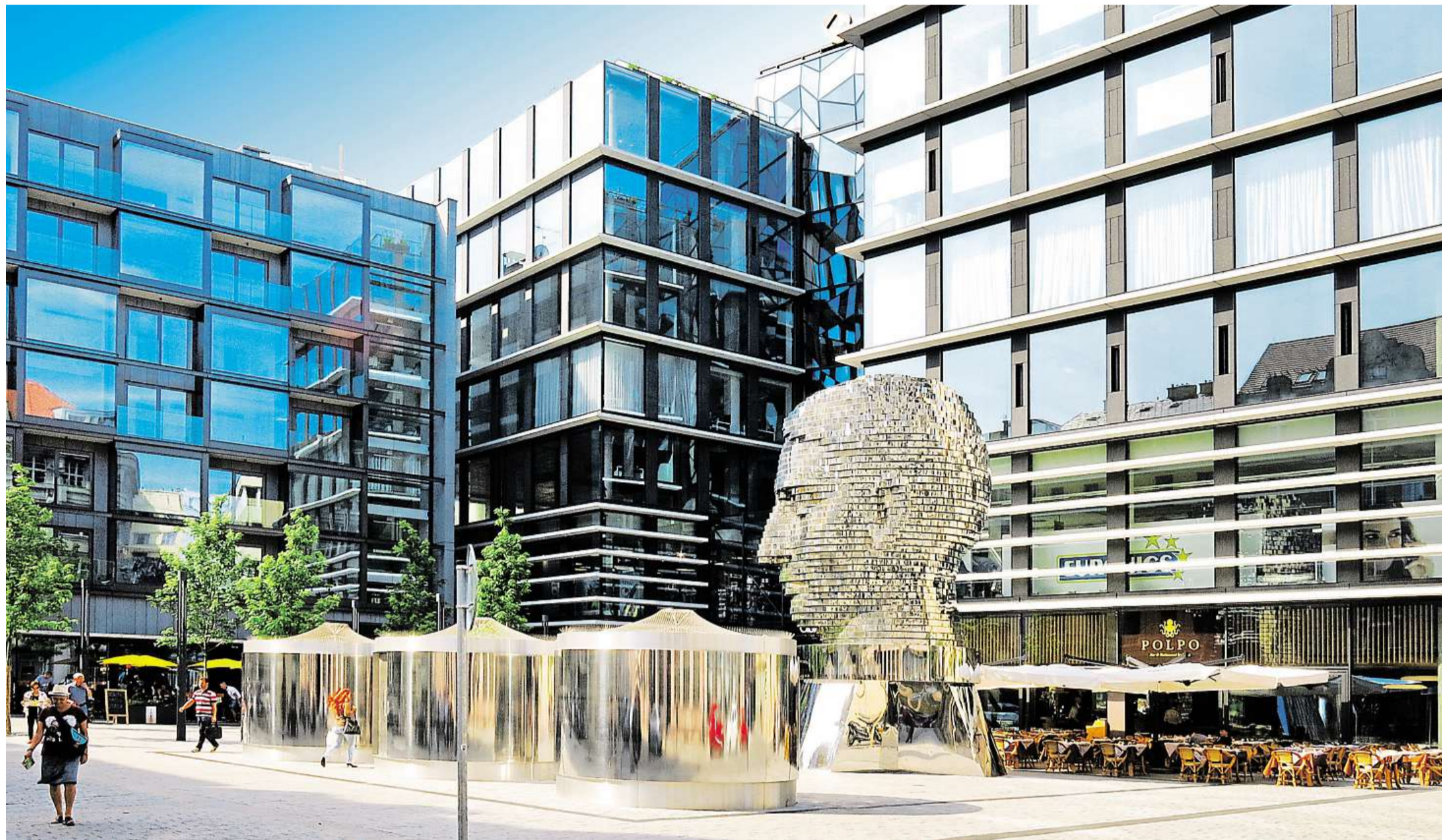
Pod Kafkovým dohledem. Za objektem Quadria zůstalo malé náměstí, které oživuje mobilní plastika od Davida Černého. Je to příjemný veřejný prostor, na nějž navazuje zdařilá obchodní pasáž, ústící do Spálené ulice. Dům vlevo je bytový. FOTO PROFIMEDIA
